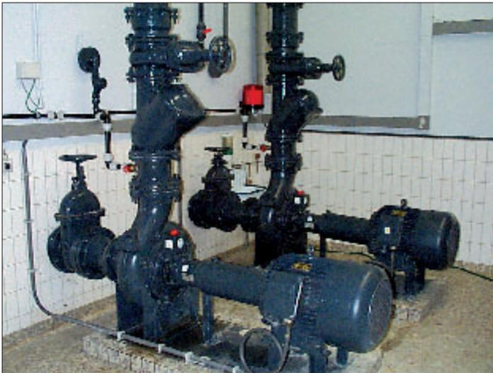
Насосы Robot “сухой” установки – правильное решение для систем перекачивающих сточные воды. Сверху: 2 насоса модели ВТ6050, осуществляющие перекачку сточной жидкости в аэропорту Амстердама “Шифол”.
